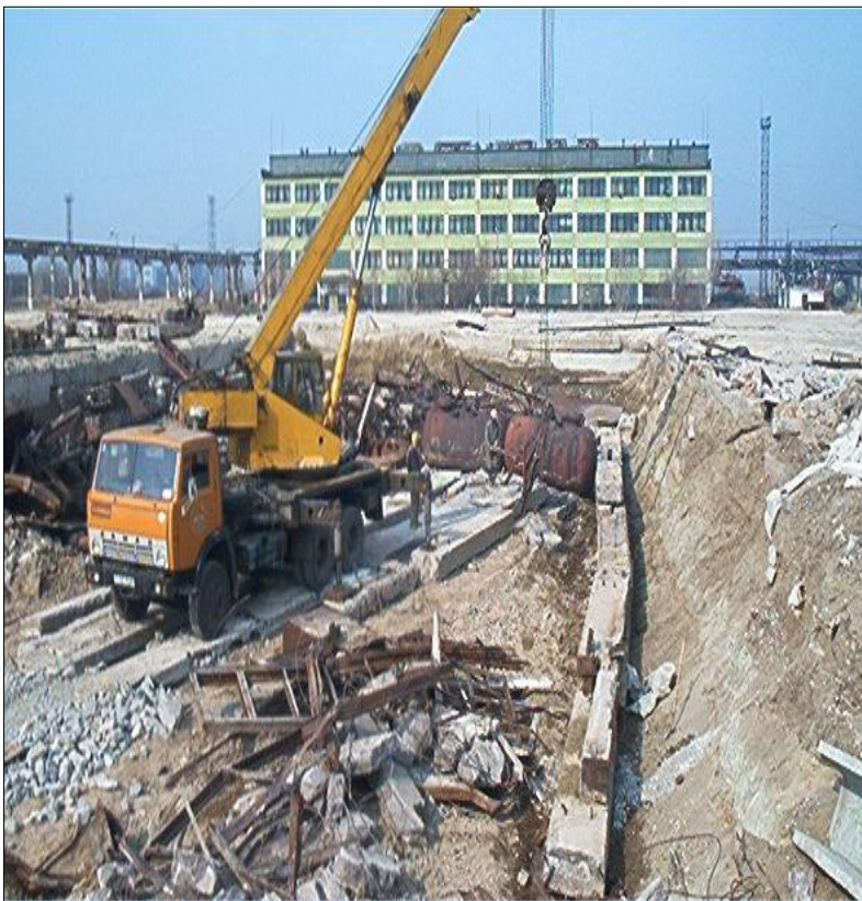
Захоронение конструкций цеха
