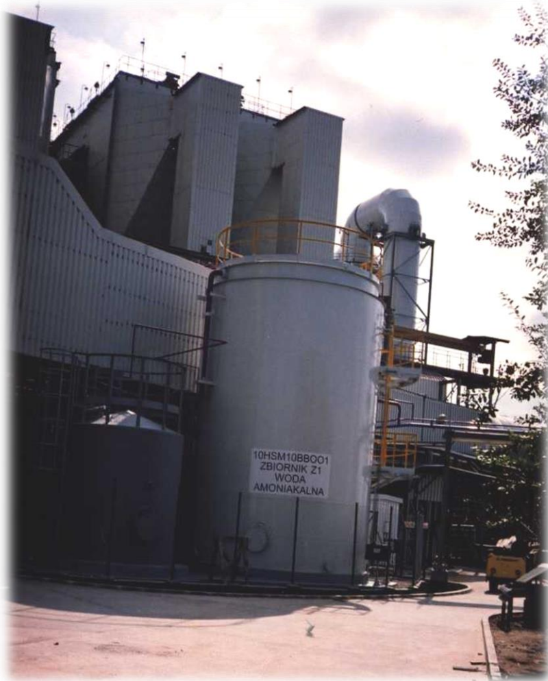
Емкости для хранения аммиака и аммиачной воды
